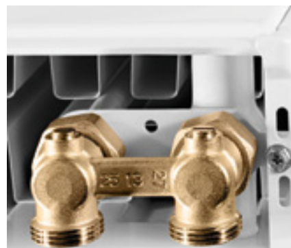
Das Ventil im Detail am Logatrend VC-Profil Flachheizkörper.
